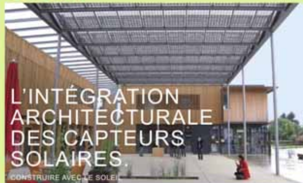
Un collecteur de capteurs photovoltaïques intégré une pièce architecturale. L'atelier d'architecture, Rambouillet © CAUE 78
